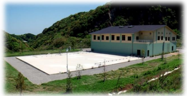
浸出水処理施設
